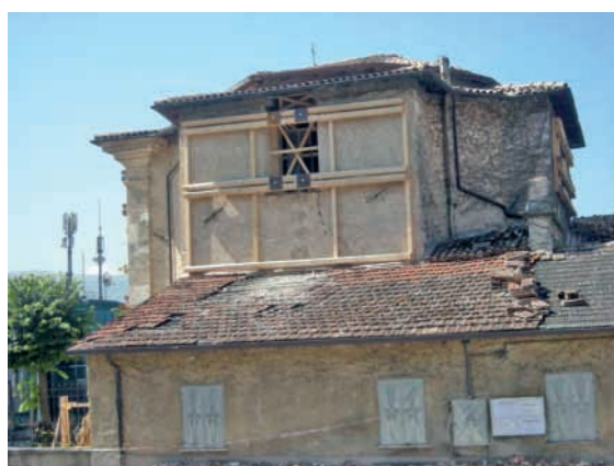
Foto 12: Tirantatura prospetto lato Via A. Arischia
