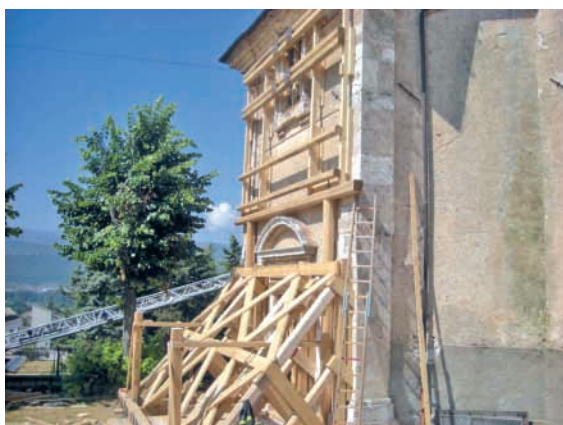
Foto 11: Puntellatura facciata principale
