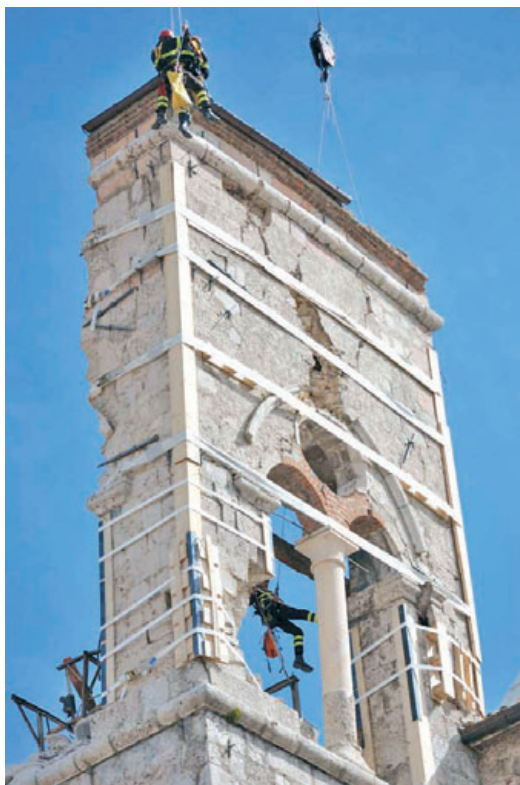
Foto 4: Cerchiatura - Torre campanaria Chiesa di S. Bernardino (AQ) con le unità S.A.F all'opera
